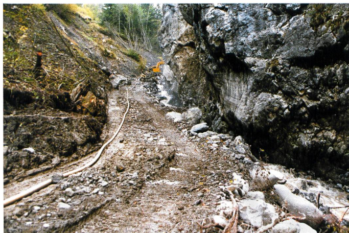
Bild 1. Bau der Blockrampe 1987; Baupiste und eingeeignetes Gerinne, Blick gegen die Fliessrichtung (Foto: J.-P. Zuppiger).
