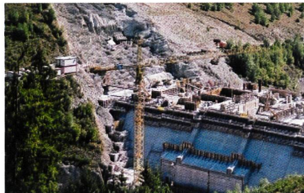
Die Talsperre Leibis/Lichte im Bau.
