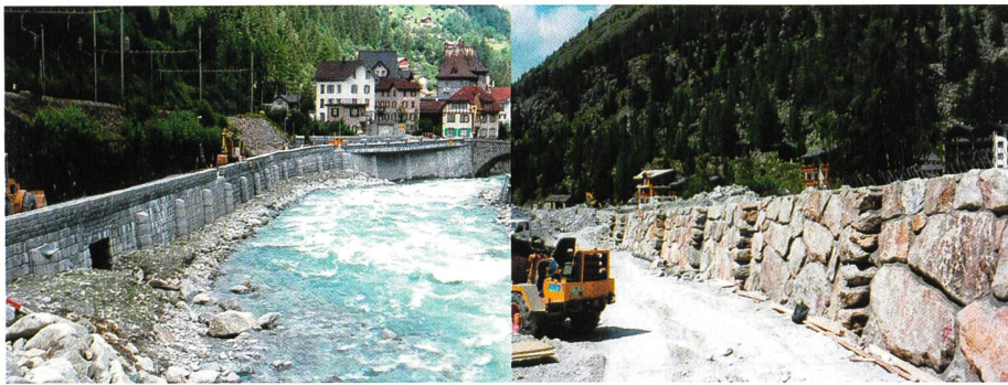
Bild 1. Ufermauern mit Rauigkeitsrippen in Gurtzellen an der Reuss (links) und in Saas Almagell an der Vispa (rechts).
