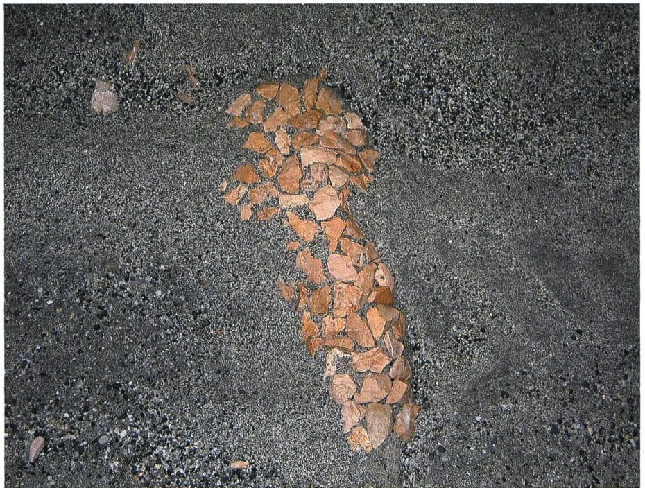
Figure 6. Recouvrement des épis par sédimentation dans le tronçon rectiligne.
