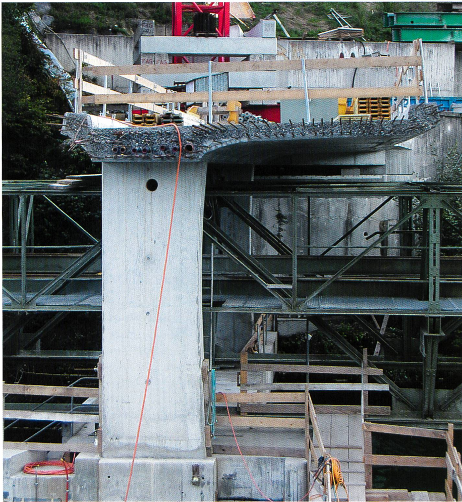
Bild 7. Fertiger Brückenquerschnitt über dem Schiffsaufzug.
