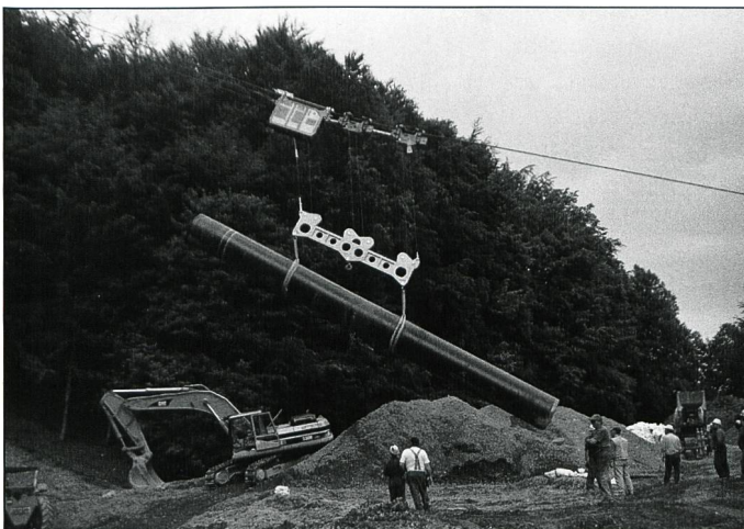
Transport und Versetzen Erdgasleitung, Rohrgewicht 12 Tonnen
