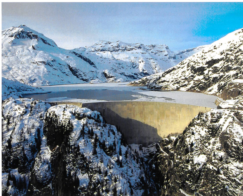
Bild 2. Luftbild der Stauanlage Emosson im Wallis.
