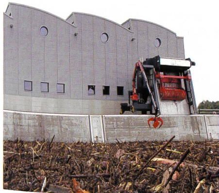
Bild 1. Geschwemmsteppich vor Einlaufrechen.
