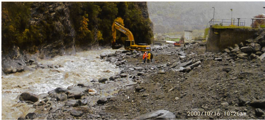
Bild 1. Abklingendes Hochwasser der Gamsa im Oktober 2000. Starke Seitenerosion im Bereich des Chemiedepots der Société Suisse des Explosifs.
