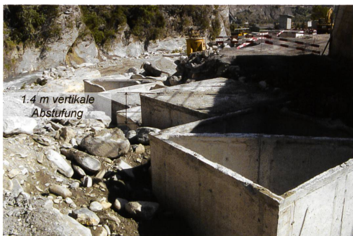
Bild 11. Links: Bau der Buhne vor dem Chemietank. Im Vordergrund eine platzierte, aber noch nicht ausbetonierte Hülle. Die Prismen sind rauheitsbildend seitlich versetzt. Rechts: Bau der Blockrampe unterhalb der bestehenden Fassung. Betonwürfel werden im Bachbett versetzt und anschliessend überdeckt.
