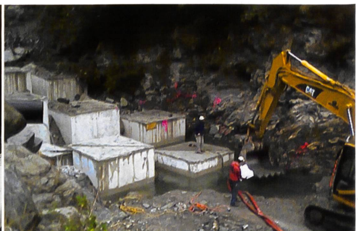
Bild 11. Links: Bau der Buhne vor dem Chemietank. Im Vordergrund eine platzierte, aber noch nicht ausbetonierte Hülle. Die Prismen sind rauheitsbildend seitlich versetzt. Rechts: Bau der Blockrampe unterhalb der bestehenden Fassung. Betonwürfel werden im Bachbett versetzt und anschliessend überdeckt.
