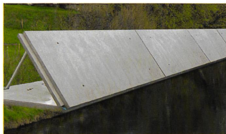
Bild 1. Der multifunktionale, kostengünstige Damersatz lässt sich normalerweise als Gehweg nutzen. Bei Hochwassergefahr lassen sich die Schutzwände innert weniger Minuten automatisch aufrichten.
