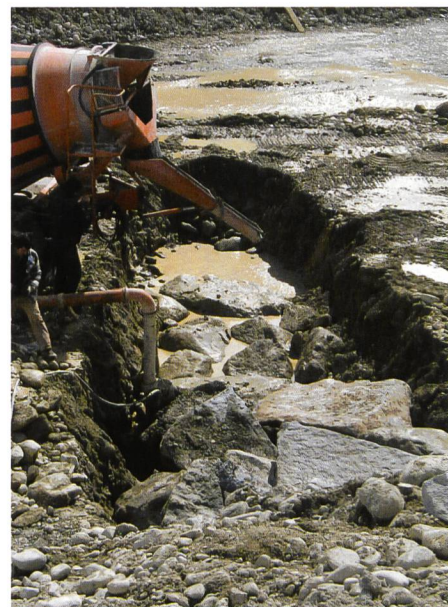
Bild 2. Bau des Querriegels am Anfang der Steilstrecke.
