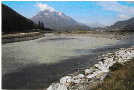
Bild 6. Baulos 6, neuer Zusammenfluss Flaz/En.
