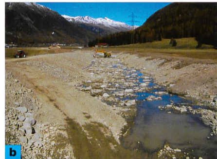
Bilder 4 a, b. Gerinnebauten im Baulos 4.
