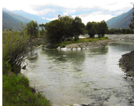
Bild 9. Baulos 12, Verlegung des Inns.
