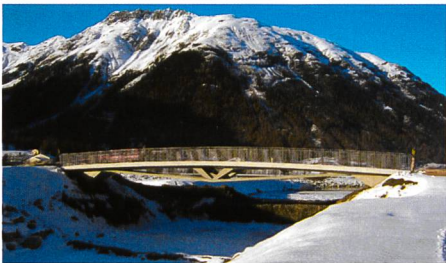
Bild 2. Brücke im Baulos 10.
