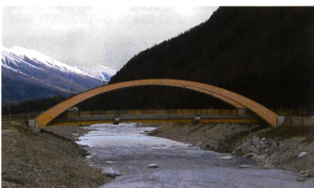
Bild 3. Brücke Acla Zambail Baulos 11.
