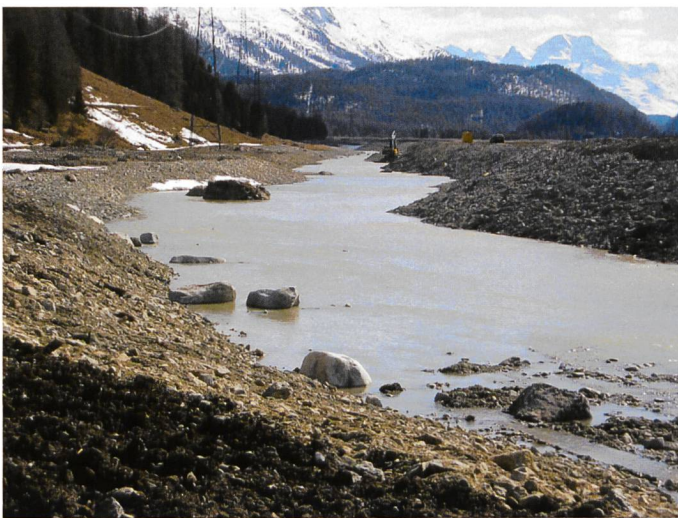
Bild 6. Für die Gestaltung der Schutzdämme des neuen Flazgerinnes wurden möglichst ortstypische Materialien verwendet. Fremdsteine wurden, wo immer möglich, kaschiert. Der Eindruck eines Dammbauwerks konnte verringert werden, indem die Blöcke in unregelmässiger, aufgelöster Form eingebracht wurden und die Böschungsneigung sowie die Uferlinie variierten. Zwischenräume oder ganze Böschungsabschnitte wurden mit Rohböden verfüllt/überdeckt und z.T. mit ortstypischen Gehölzen bestockt. Am Böschungsfuss wurden mit geeigneten Blöcken Deckungsstrukturen für Fische geschaffen (Fotos: Pitsch/Rey).
