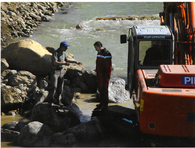
Bild 5. Der ökologische Baubegleiter ist am Bau mit weit reichenden Befugnissen ausgestattet. So gibt er der Bauleitung und dem Baggerführer konkrete Anweisungen zur Massnahmenumsetzung (links). Um alternative Möglichkeiten der Gerinnegestaltung und Strömunglenkung zu finden, veranlasst der Baubegleiter an Versuchsstrecken Tests mit unterschiedlichem Material und unterschiedlichen Uferverläufen (Fotos: Rey).
