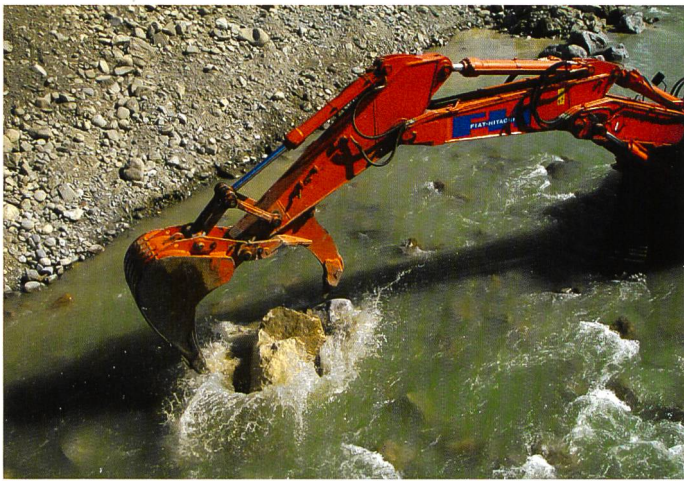
Bild 8. Im steileren Abschnitt des neuen Flazgerinnes wurde die Erosion durch starke Sohlenbeschwerung mit Naturblöcken verhindert. Der Baubegleiter sorgte dafür, dass keine unnatürlichen, regelmässigen Muster entstanden und so ein naturnaher gebirgsbachtypischer Lebensraum geschaffen wurde (Fotos: Rey).
