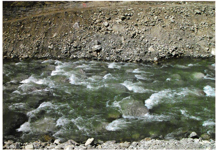
Bild 8. Im steileren Abschnitt des neuen Flazgerinnes wurde die Erosion durch starke Sohlenbeschwerung mit Naturblöcken verhindert. Der Baubegleiter sorgte dafür, dass keine unnatürlichen, regelmässigen Muster entstanden und so ein naturnaher gebirgsbachtypischer Lebensraum geschaffen wurde (Fotos: Rey).
