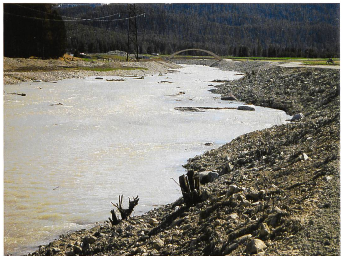
Bild 6. Für die Gestaltung der Schutzdämme des neuen Flazgerinnes wurden möglichst ortstypische Materialien verwendet. Fremdsteine wurden, wo immer möglich, kaschiert. Der Eindruck eines Dammbauwerks konnte verringert werden, indem die Blöcke in unregelmässiger, aufgelöster Form eingebracht wurden und die Böschungsneigung sowie die Uferlinie variierten. Zwischenräume oder ganze Böschungsabschnitte wurden mit Rohböden verfüllt/überdeckt und z.T. mit ortstypischen Gehölzen bestockt. Am Böschungsfuss wurden mit geeigneten Blöcken Deckungsstrukturen für Fische geschaffen (Fotos: Pitsch/Rey).
