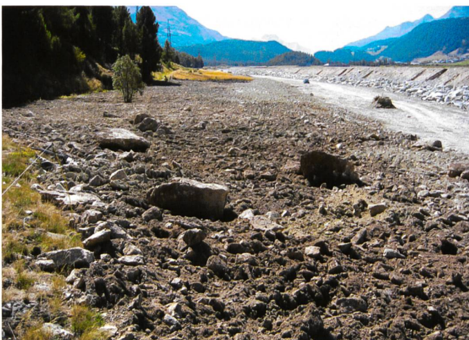
Bild 7. Eine harmonische Angleichung zwischen Gerinne und Geländeprofil erfolgte überall dort, wo der Entwicklungsplan den hierfür benötigten Raum offen liess. Links: restrukturierter Übergang vom neuen Flazgerinne (vor der Flutung) zum Hangfuss des Muottas Muragl. Rechts: An den Ufern des neu gestalteten Flaz vegl werden die alten Hochwasserdämme (Hintergrund) eingerissen und das Geländeniveau der Ufer an das des Umlandes angeglichen (vgl. auch Bild 2, unten) (Fotos: Pitsch/Rey).
