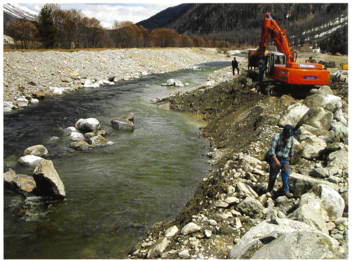
Bild 5. Der ökologische Baubegleiter ist am Bau mit weit reichenden Befugnissen ausgestattet. So gibt er der Bauleitung und dem Baggerführer konkrete Anweisungen zur Massnahmenumsetzung (links). Um alternative Möglichkeiten der Gerinnegestaltung und Strömunglenkung zu finden, veranlasst der Baubegleiter an Versuchsstrecken Tests mit unterschiedlichem Material und unterschiedlichen Uferverläufen (Fotos: Rey).
