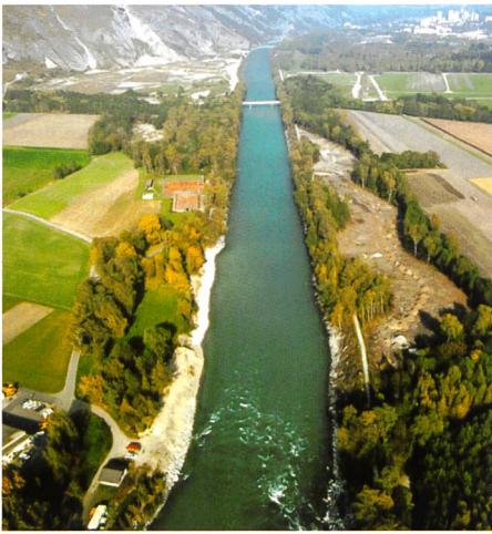
Bild 1. Rheinaufweitung Chur, Zustand 1994 nach Arbeitsbeginn (Bild: Tiefbauamt Graubünden).
