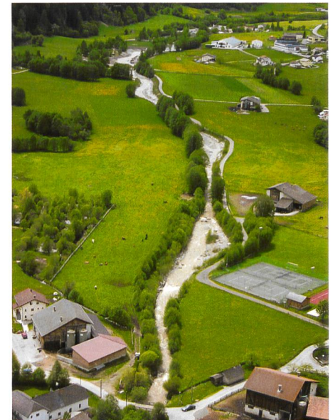
Bild 3. Aufweitungen Rombach Münstair (Bild: Pio Pitsch).
