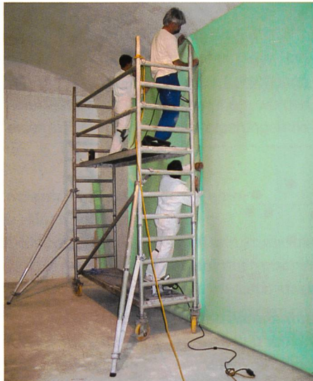
Bild 1. Sichere System- und Verarbeitungstechnik: Wände – in Birrwil 4,5 m hoch – und Böden der Trinkwasserbecken wurden mit der Dichtungsbahn Sarnafil MC G 780-15 abgedichtet. Auf diese Weise wurde eine wasserdichte Innenhaut hergestellt.
