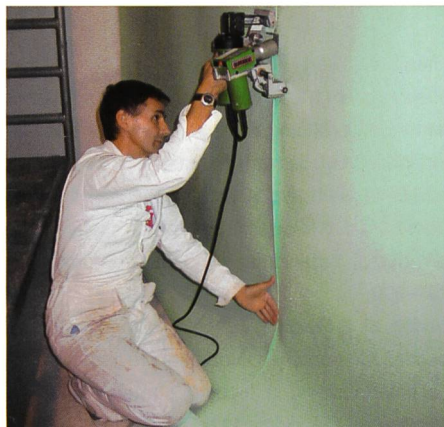
Bild 2. Das Verbinden der Bahnen erfolgt durch Heissluftschweissen mit speziellen Schweissautomaten oder Handföhn. Das Sarnafil-System ist vom Schweizerischen Verein des Gas- und Wasserfaches SVGW zertifiziert und zugelassen.
