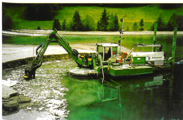
Bild 6. BKW-Schwimmbagger im Einsatz.
