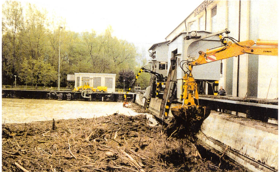
Bild 1. Starker Geschwemmselanfall am Rechen des Rheinkraftwerks Albbruck-Dogern beim Maihochwasser 1991. Innerhalb von zwei Tagen fielen insgesamt rund 4000 m 3 Geschwemmsel an, was dem Transportvolumen von ca. 500 Lastwagen entsprechen würde.
