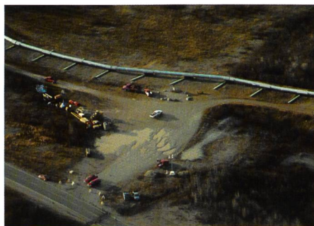
Bild 1. Gleitverschiebungen der Trans-Alaska-Pipeline im Bereich der Denali-Verwerfung (2002 Denali-Erdbeben) (links) und Auflagerschäden der Pipeline infolge Bodenbewegungen.
