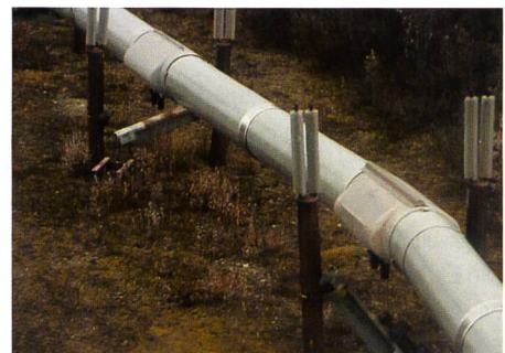
Bild 1. Gleitverschiebungen der Trans-Alaska-Pipeline im Bereich der Denali-Verwerfung (2002 Denali-Erdbeben) (links) und Auflagerschäden der Pipeline infolge Bodenbewegungen.
