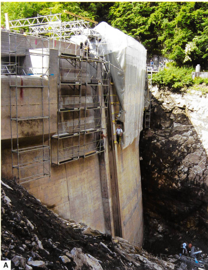
Bild 6. Während (links) und nach (rechts) erfolgter Riss-Sanierung.
