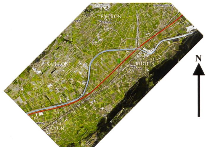
Figure 2. Vue aérienne du site retenu (en rouge l'autoroute).
