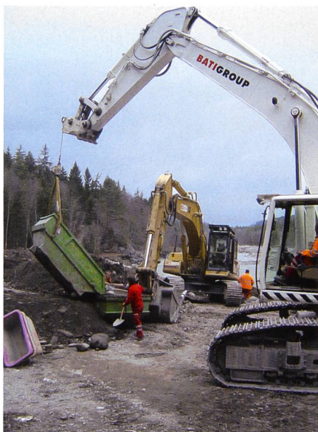
Bild 16. Bauüberwachung und Qualitätssicherung, Siebung zur Volumenzahlanalyse des Aushubmaterials der Aufweitung.
