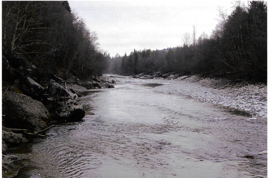
Bild 1. Kander vor Baubeginn 2004; begradigter, durch viele Buhnen eingegengter Flusslauf mit Breiten um die 32 m; Sohle eingetieft, Auendynamik weitgehend verschwunden.
