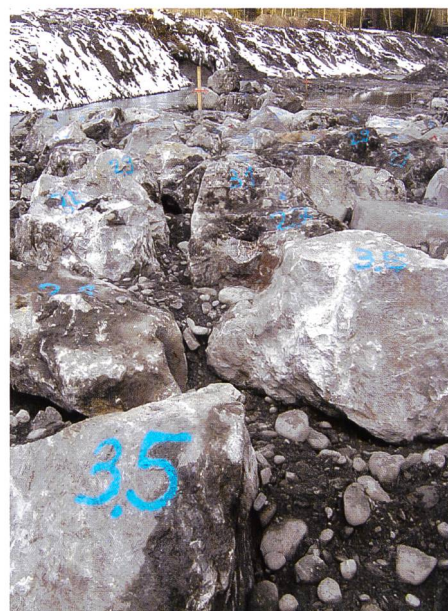
Bild 18. Bauüberwachung und Qualitätssicherung, angeschriebene Massen auf Einzelblöcken.
