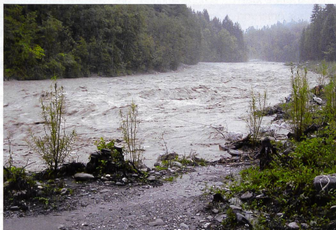
Bild 19. Abfluss von ca. 460 m 3 /s auf der Blockrampe am Vormittag des 22.8.05.
