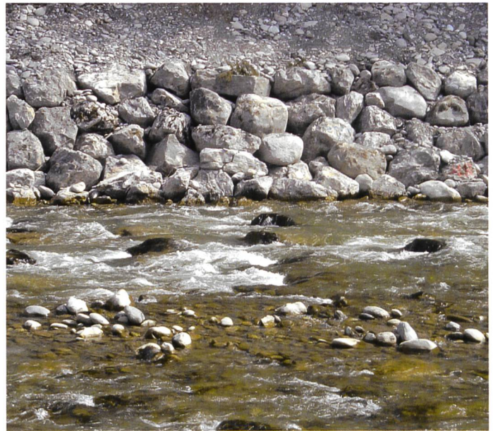
Bild 22. Naturnahe Sohlenstruktur auf der Blockrampe nach Auswaschen der Feinanteile aus der Überschüttung.
