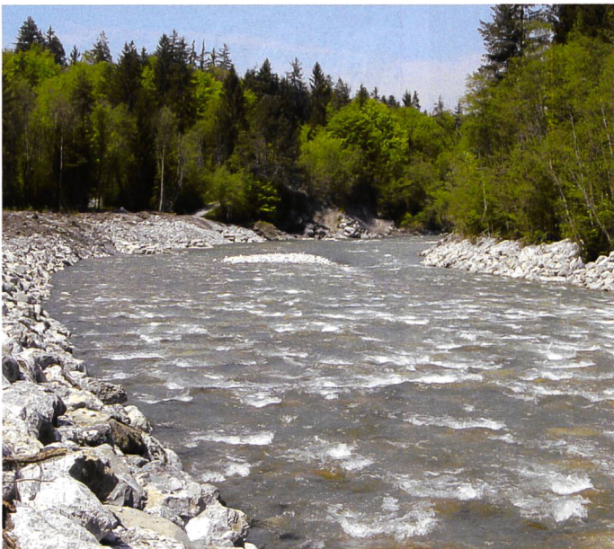
Bild 21. Blick flussaufwärts auf die fertige Blockrampe.
