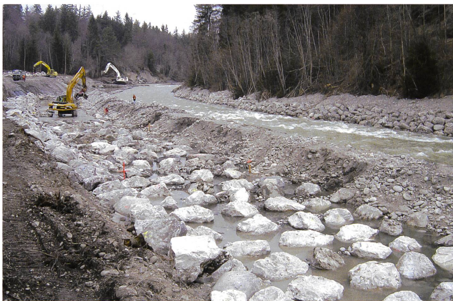
Bild 15. Umleitung Kander über bereits fertig gestellten Teil der Blockrampe und Bau der zweiten Hälfte.
