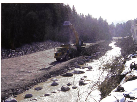
Bild 14. Übersütten der Blöcke, Abschluss erste Phase beim Bau der Blockrampe.
