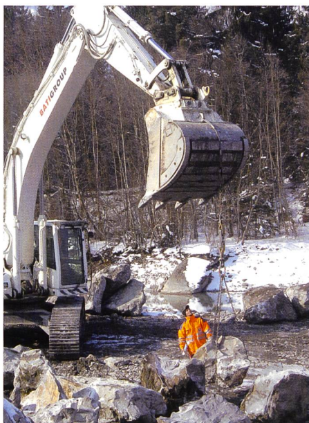
Bild 17. Bauüberwachung und Qualitätssicherung, Wiegen der Einzelblöcke.
