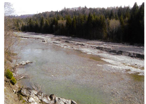
Bild 3. Blick auf den bereits aufgeweiteten Teil unterhalb der Blockrampe.
