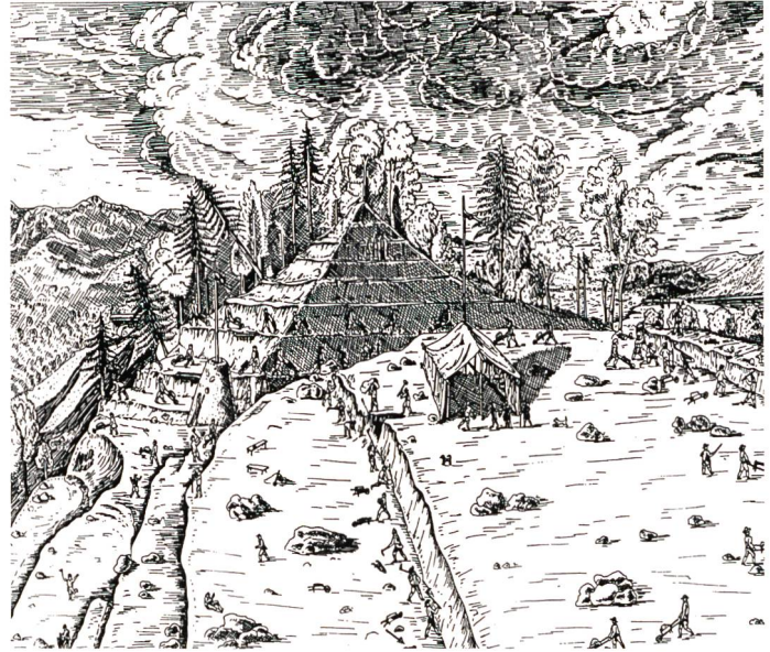
Bild 2. Arbeiten am Kanderdurchstich, Skizze von T. Bürgin nach einem zeitgenössischen Gemälde von 1714.
