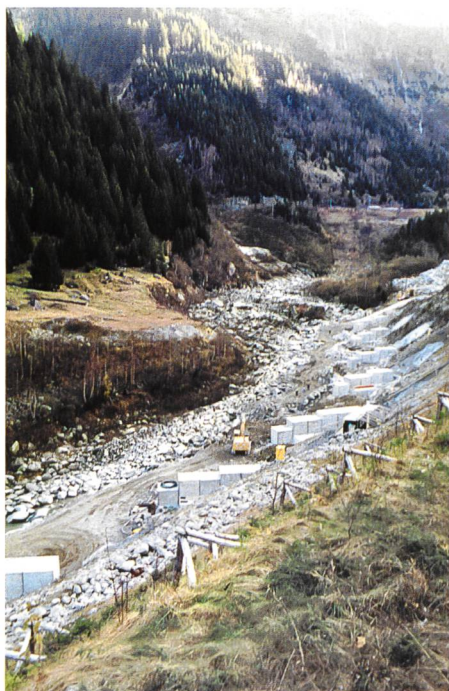
Bild 8. Bau der 10 aus Prismen bestehenden, deklinant angeordneten Bühnen auf der Höhe des Teufelsteins bei Göschenen (Blick flussaufwärts).
