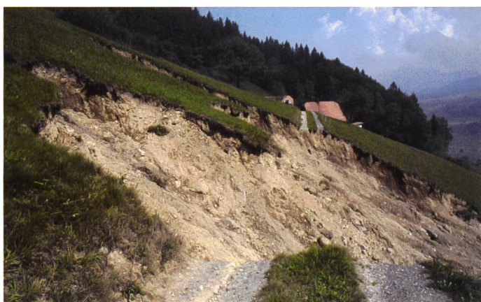
Bild 10. Die Starkregenfälle verursachten im Entlebuch unzählige Erdrutsche. Dabei kamen zwei Feuerwehrmänner ums Leben. Viele Verkehrswege wurden für Tage unterbrochen.
