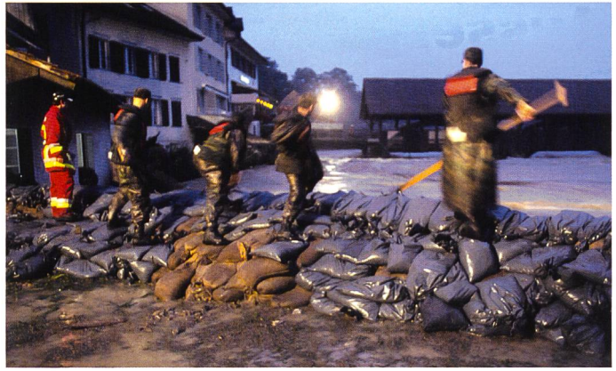
Bild 4. Militär und Feuerwehr versuchen die gefährlich hohe Reuss in Bremgarten mit Sandsäcken in Schach zu halten.
