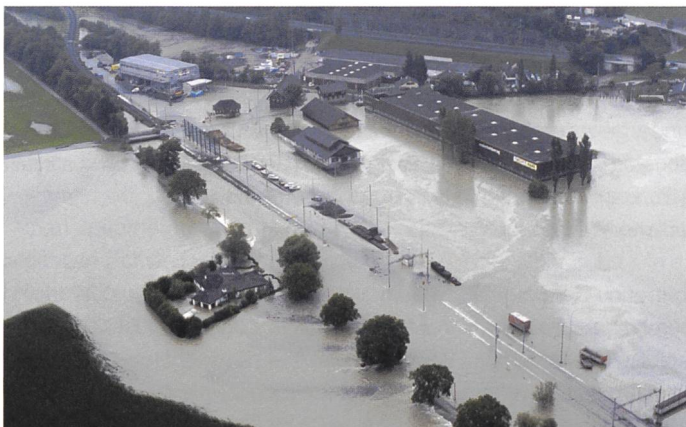
Bild 1. Überschwemmte Bahnlinie in Sachseln ÖW.
