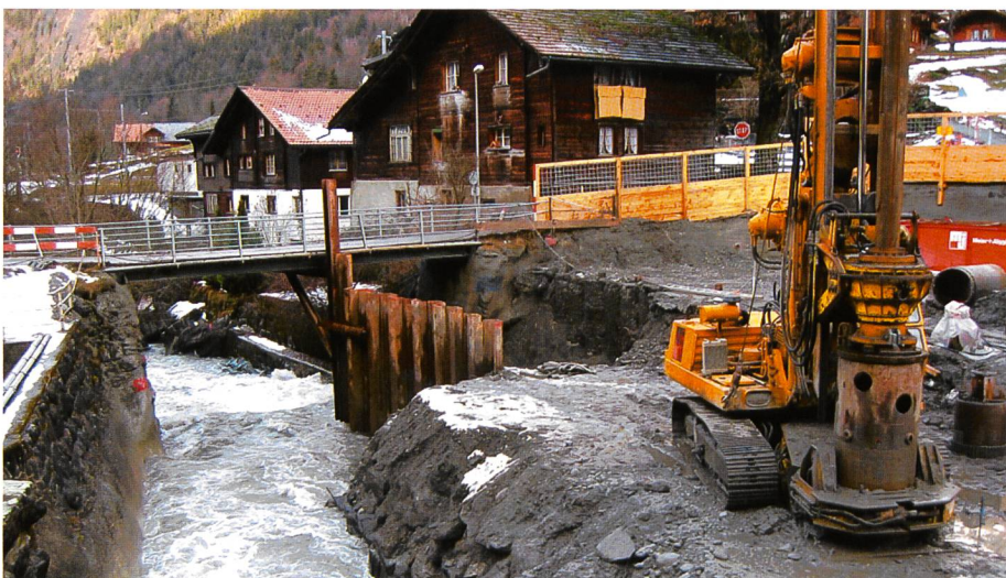
Bild 1. Vorgebohrte Spundwände als Baugrubenabschluss.
