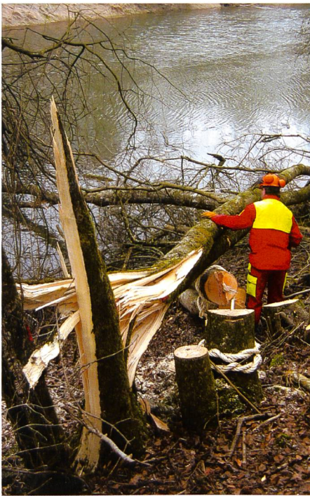
Bild 1. Diese Raubbaumgruppe im Unterwasserkanal des Kraftwerks Rapperswil wird auch dem Hochwasser standhalten. Der geringe Mehraufwand für das Anbinden mit einem Sisalseil lohnt sich (Foto: H. Dorer).
