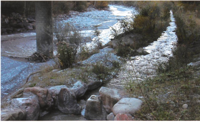
Bild 10. Ziel der Erneuerungsarbeiten am Mühlbach war die Fischbarmachung des Kanals, um die hohen Schwellen des unteren Landquart-Abchnitts umgehen zu können.
