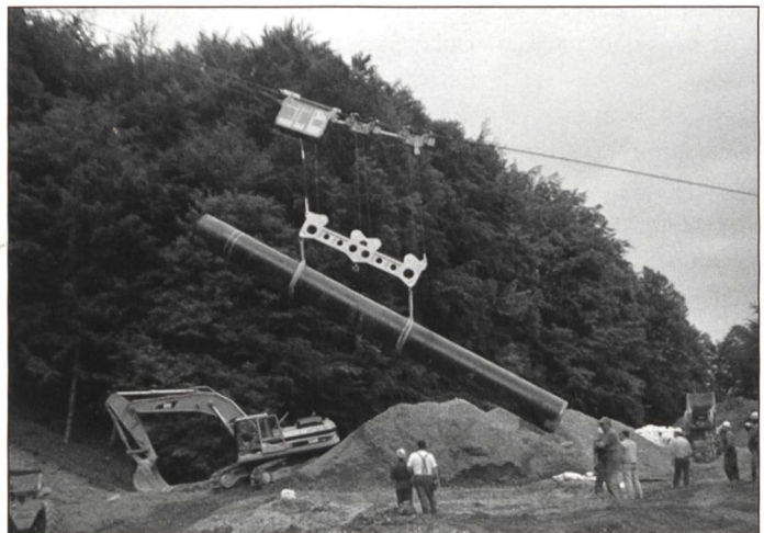
Transport und Versetzen Erdgasleitung, Rohrgewicht 12 Tonnen
