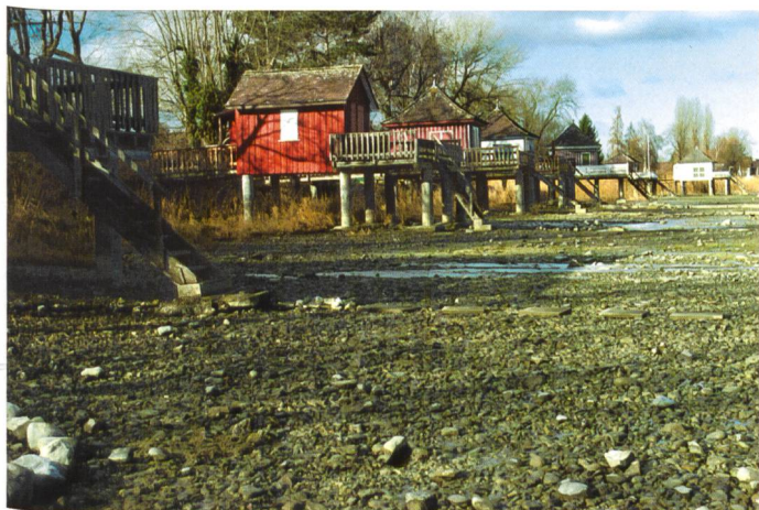
Bild 1. Die Strandhäuschen in Kesswil stehen auf dem Trockenen.
