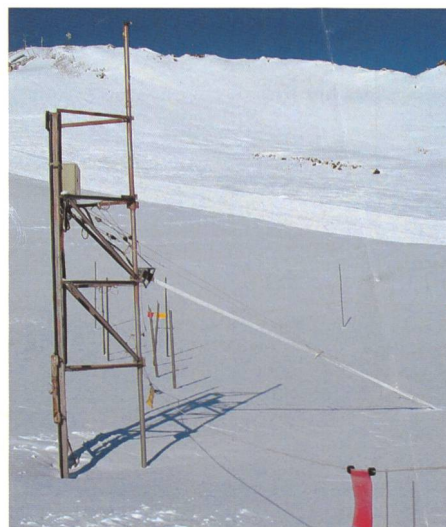
Bild 2. Installation des Snowpower-Sensors auf dem Weissfluhjoch Davos.
