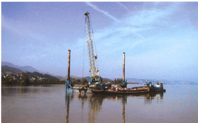
Bild 10. Die aufwändige Schüttung des Brandungswalls mit Grobkies vom Ledischiff aus.
