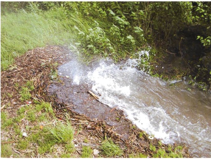
Bild 4. Erosion: Die Wellen erzeugen Fontänen, welche aus dem unterspülten Ufersaum ausbrechen.
