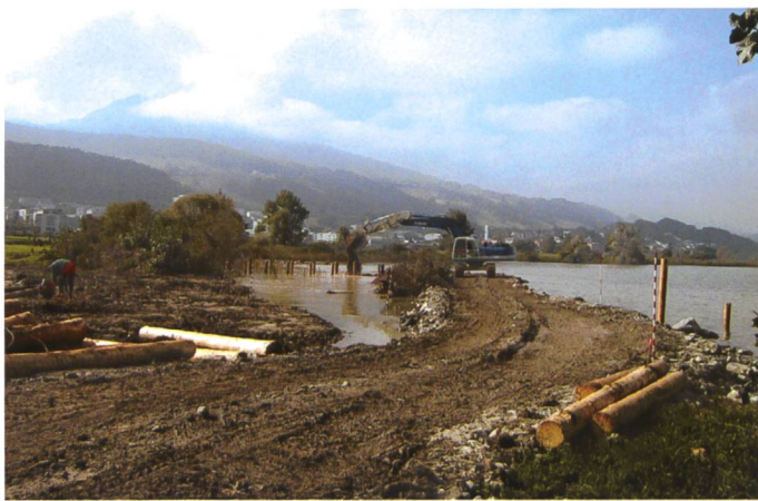
Bild 8. Baupiste im See, erstellt für die Vorschüttung von Aushubmaterial aus der Lagune.
