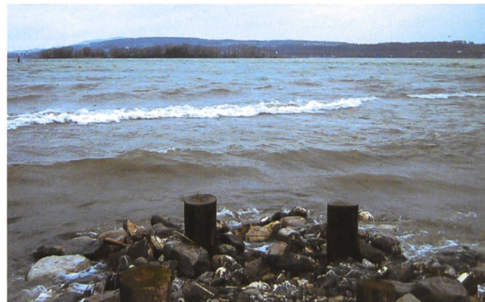
Bild 11. Der Brandungswall wirkt, die Wellen verlieren einen Teil ihrer zerstörerischen Kraft.
