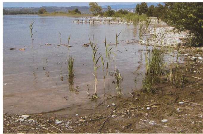
Bild 9. Fertige Schüttung mit Rest-Röhricht im Vordergrund und neuen Buhnen im Hintergrund.
