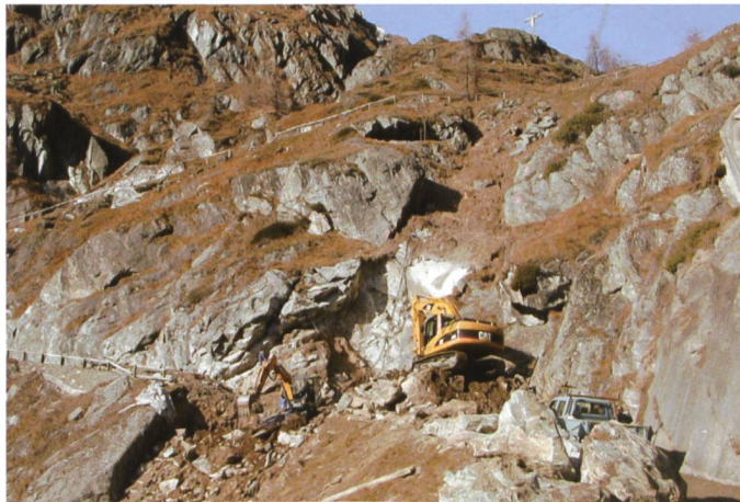
Bild 2. KW Dorferbach: Verlegung der Druckleitung in einem Steilhang auf 1950 m Meereshöhe.
