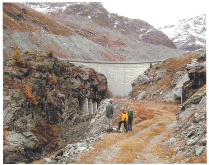
Figure 4. Vue aval du barrage de Tourtemagne.
