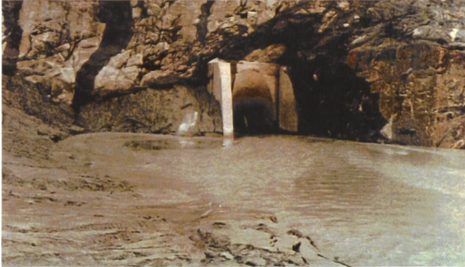
Bild 3. Sedimente vor Grundablass des Stausees Mauvoisin während der Entleerung im Mai 1985.
