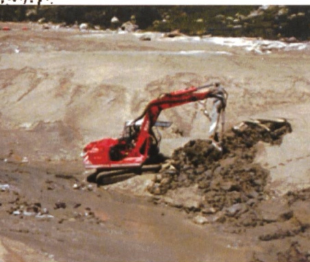
Figure 13. A gauche: Disposition des tas dans la retenue pour le curage du bassin; à droite: augmentation de l'efficacité du curage par déplacement des matériaux solides à l'intérieur de la retenue à l'aide de moyens mécaniques (photo: D. Job, Colenco).
