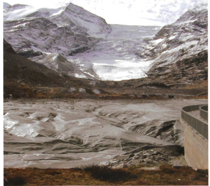
Figure 6. Ensablement du barrage de Tourtemagne.
