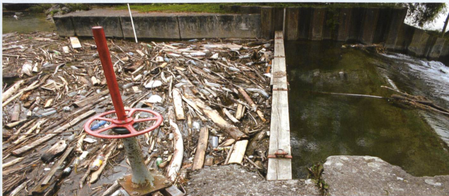
Bild 5. Senkbalken beim Ausfluss eines Geschwemmselbeckens.
