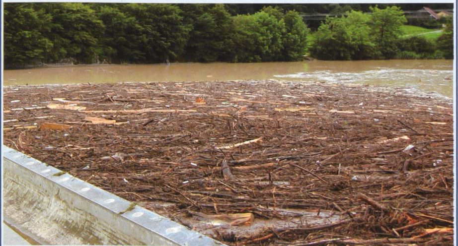
Bild 1. Schwemmgutteppich am Rechen des Wasserkraftwerks Bannwil an der Aare (CH) während eines Hochwassers 2002; Foto: Fritz Grogg, bkw-fmb Energie AG.
