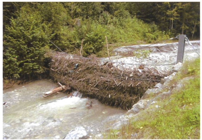
Bild 9. links: Seilnetzsperrre Burgleitenbach, Lkr. Weilheim-Schongau; rechts: Seilnetzsperrre Kanker, Lkr. Garmisch-Partenkirchen.
