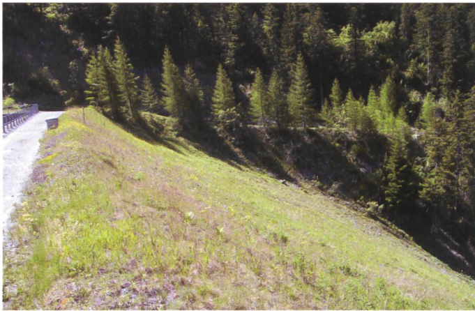
Bild 2. Linkes Dammwiderlager mit luftseitiger Böschung.
