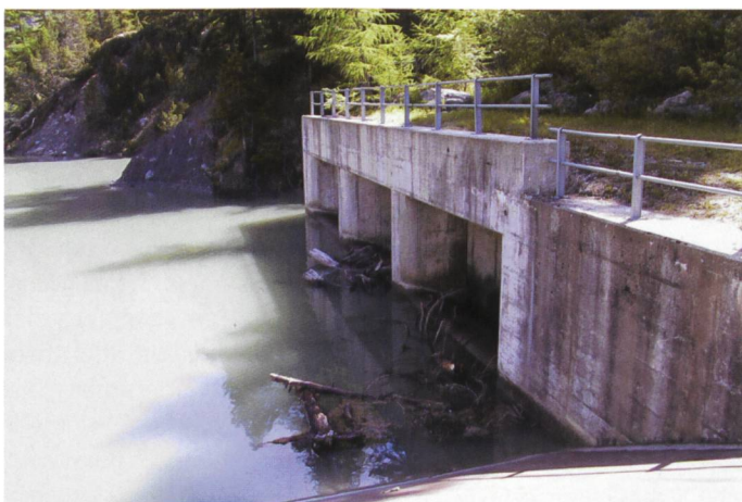
Bild 8. Einlauf der Hochwasserentlastung mit Schwemmholz.
