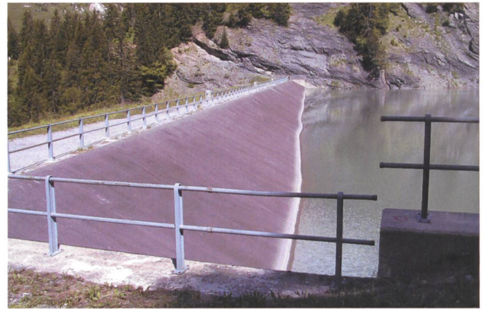
Bild 3. Oberwasserseitige Dammböschung mit rechtem Widerlager.
