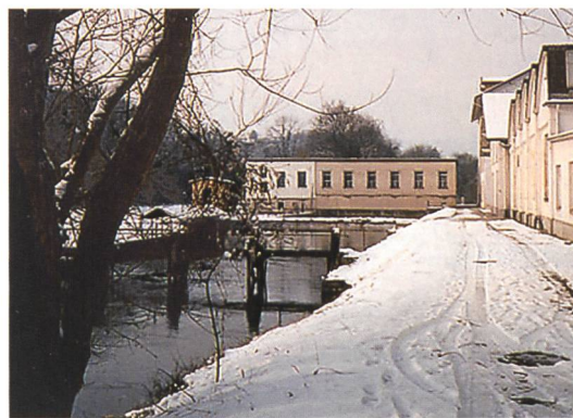
Bild 2, oben links. Die Erneuerung des Kleinwasserkraftwerks StroppeI wurde unter Wahrung der historischen Technik durchgeführt und hat dennoch eine markante Leistungssteigerung ermöglicht. Bild 3, oben Mitte. Beim Umbau des Kraftwerks StroppeI wurde einerseits auf die historisch wertvollen Anlagenkomponenten Rücksicht genommen, andererseits mit neuen Getrieben und Generatoren eine markante Leistungssteigerung erreicht. Bild 4, oben rechts. Mit dem Kleinwasserkraftwerk StroppeI und dem alten Industriegelände kann die Proma Energie AG Elektrizität erzeugen und zudem Räumlichkeiten im angegliederten Gewerbezentrum anbieten.
