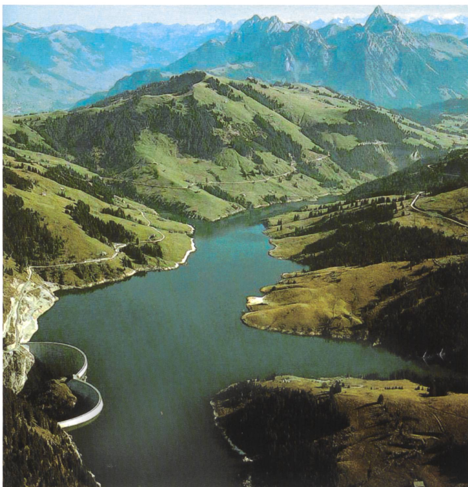
Figure 1. Barrages de l'Hongrin.
