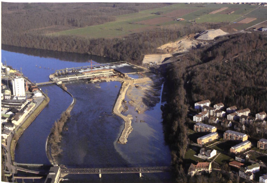
Bild 1. Luftaufnahme vom Dezember 2006, während die Bauarbeiten am Stauwehr beinahe abgeschlossen sind, beginnen am Schweizer Ufer (rechts) die Vorbereitungen für den Bau des Maschinenhauses.
