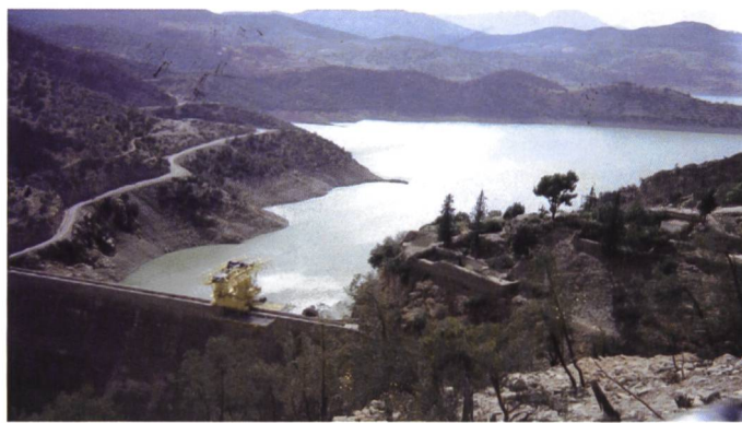
Photo1. Vue générale du barrage de Oued El Fodda (Remini B., 2000).
