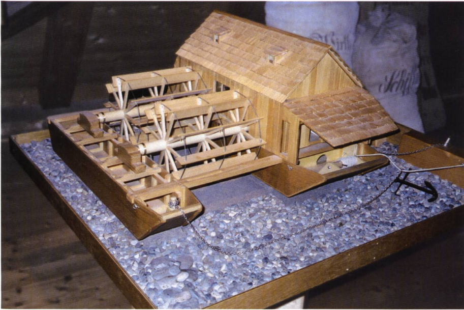
Bild 5. Rechtsufrige Schiffmühle in Eglisau, Modell im Ortsmuseum, erstellt nach historischen Bildern ab 1730 (Foto des Verfassers).
