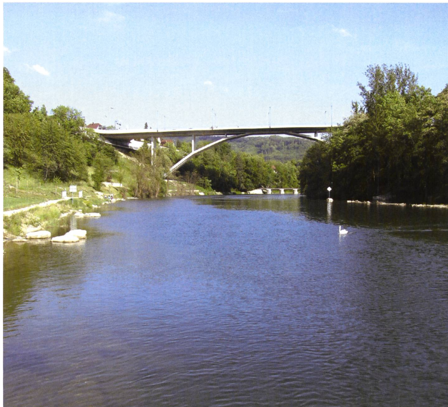
Bild1. Blick auf den neuen Stauraum des Kraftwerks Kappelerhof.
