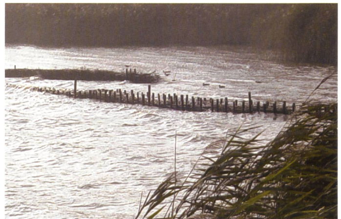
Bild 3. Wellendämpfende Wirkung von Lahnungen.
