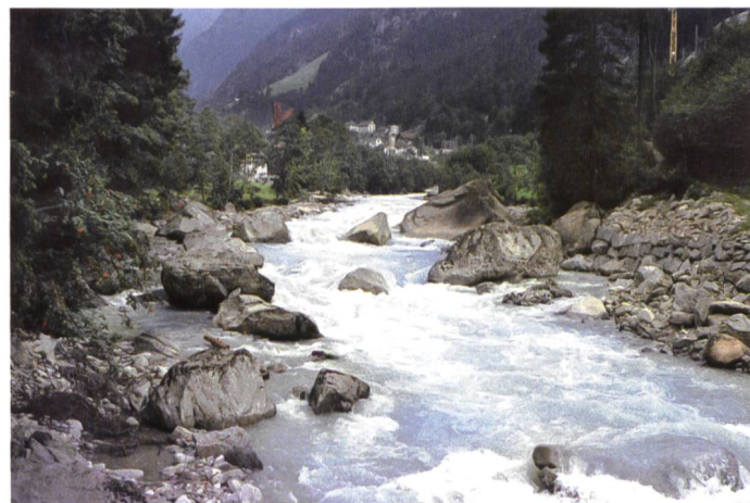
Bild 1, links. Aufgelöste unstrukturierte Blockrampe in der Simme bei St. Stephan (Blick gegen Fließrichtung); rechts: grosse isoliert liegende Blöcke in der Reuss (Blick gegen Fließrichtung).
