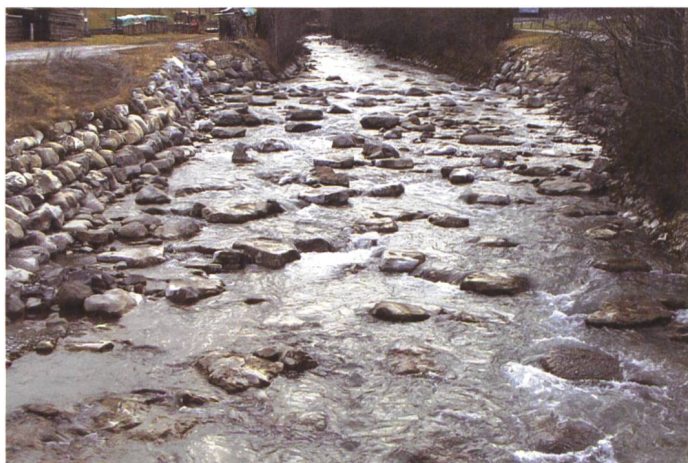
Bild 1, links. Aufgelöste unstrukturierte Blockrampe in der Simme bei St. Stephan (Blick gegen Fließrichtung); rechts: grosse isoliert liegende Blöcke in der Reuss (Blick gegen Fließrichtung).
