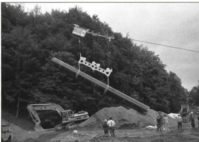
Transport und Versetzen Erdgasleitung, Rohrgewicht 12 Tonnen
