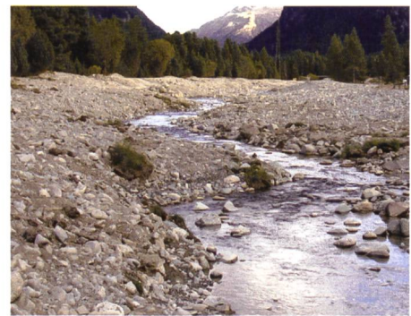
Bild 3. Von der Ova da Bernina übernommene Strukturmerkmale im Flaz vegl: Linienführung, Horizontal-, Vertikalstruktur, Ufer-Gerinne-Verzahnung, Substratkörnung, -mosaik und -material, Strömungsstörungen, Ausprägung von Böschungsfuss und Ufer.
