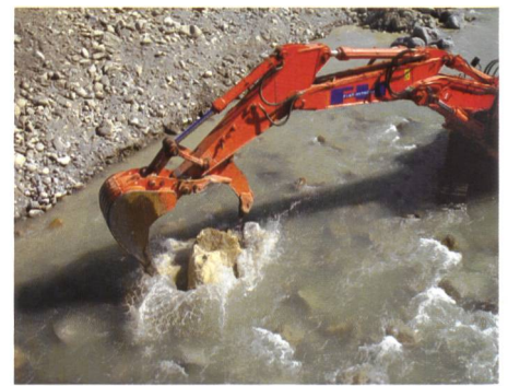
Bild 5. Ökologische Baubegleitung: Der ökologische Baubegleiter ist am Bau mit weitreichenden Befugnissen ausgestattet. So gibt er der Bauleitung und dem Baggerführer konkrete Anweisungen zur Massnahmenumsetzung. In den hier vorgestellten Beispielen bespricht der ökologische Baubegleiter die richtige Positionierung von Sohlblöcken als Stabilisierungs- und Strukturierungselemente im Neuen Flaz.
