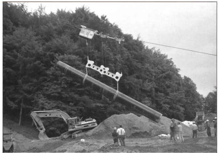
Transport und Versetzen Erdgasleitung, Rohrgewicht 12 Tonnen
