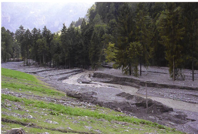
Bild 4. Ablagerungen im Secklisbach oberhalb der Staustufe Chäppelistutz, Aufnahme vom 30. August 2005.
