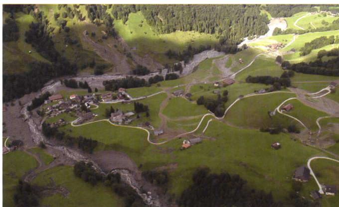
Bild 12. Haldibach und Secklisbach, Aufnahme vom 26. August 2005. Am oberen Bildrand erkennt man den Stauraum Chäppelistutz. Die Schwemmebene des Secklisbaches wird jetzt teilweise rekultiviert.
