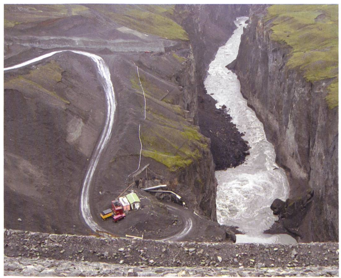
Bild 2. Schlucht im Unterwasser, gesehen von der Krone des Kárahnjúkar Damms: Am linken oberen Rand ist das Ende der Schussrinne erkennbar.
