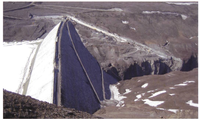
Bild 4. Kárahnjúkar Damm mit der Hochwasserentlastungsanlage Ende April 2007 (Bild Landsvirkjun).
