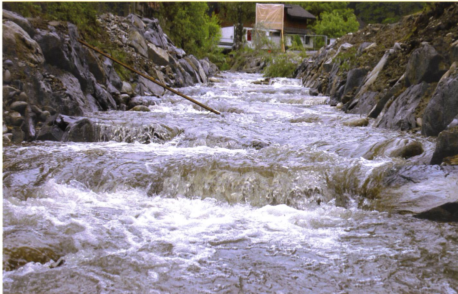
Bild 1. Scherlibach mit fertig gestellter Pendelrampe.
