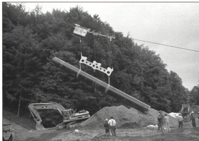
Transport und Versetzen Erdgasleitung, Rohrgewicht 12 Tonnen
